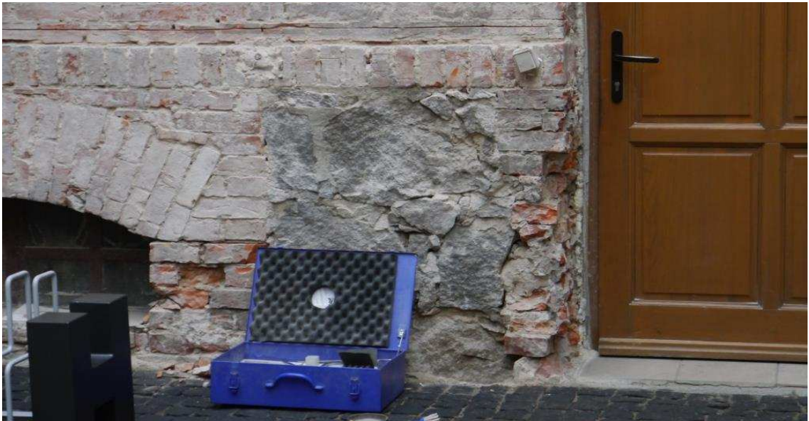
Zdj. nr 10. Uszkodzenia muru przy wejściu
