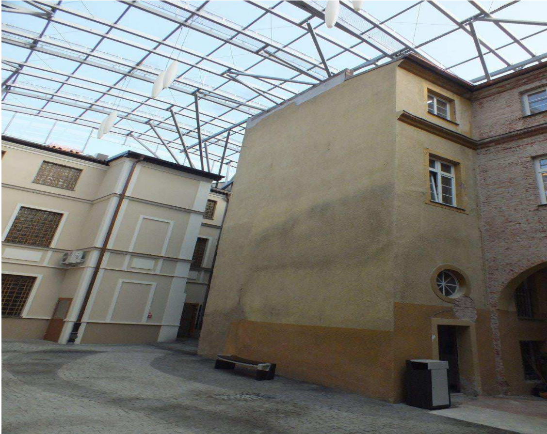
Zdj. nr 4 Elewacja Zachodnia z zachowanym tynkiem cementowym
