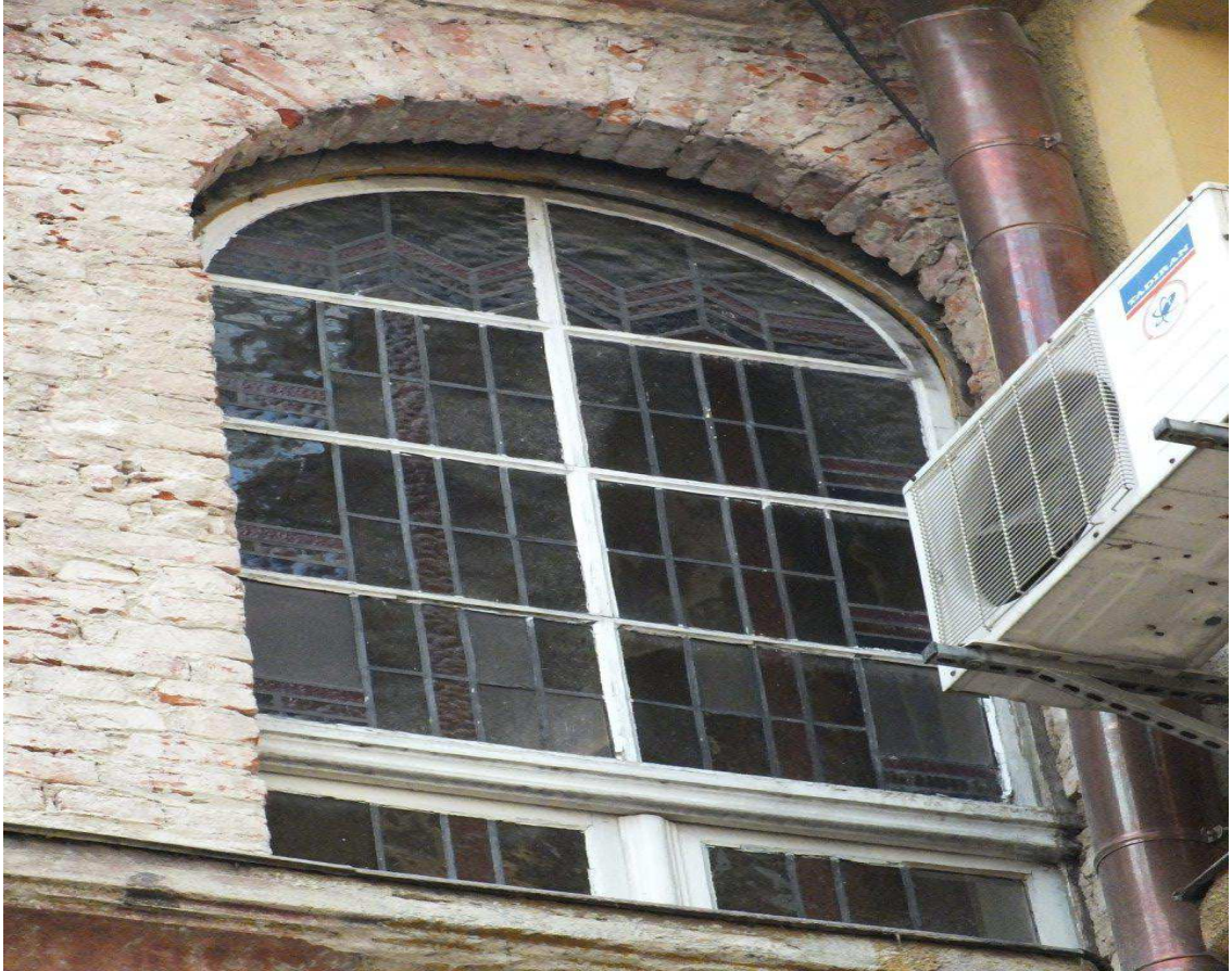
Zdj. nr 12 Stolarka okienna wraz z witrażem do renowacji
