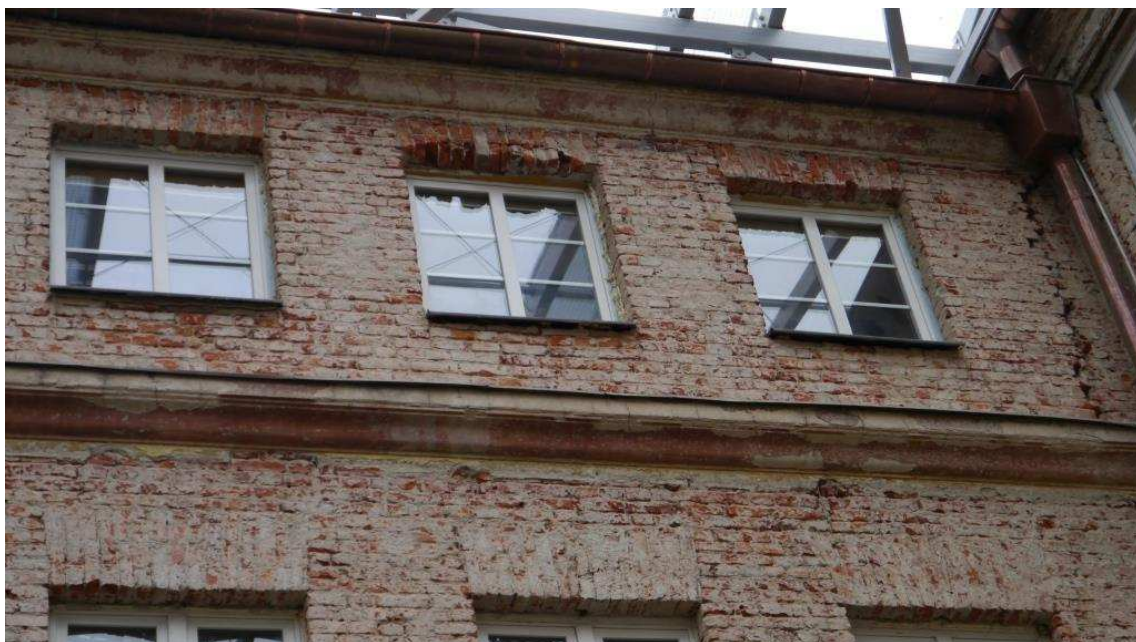
Zdj. nr 20. Uszkodzenia nadproży
