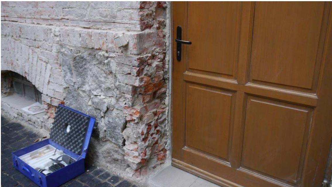
Zdj. nr 13. Uszkodzenia muru przy wejściu
