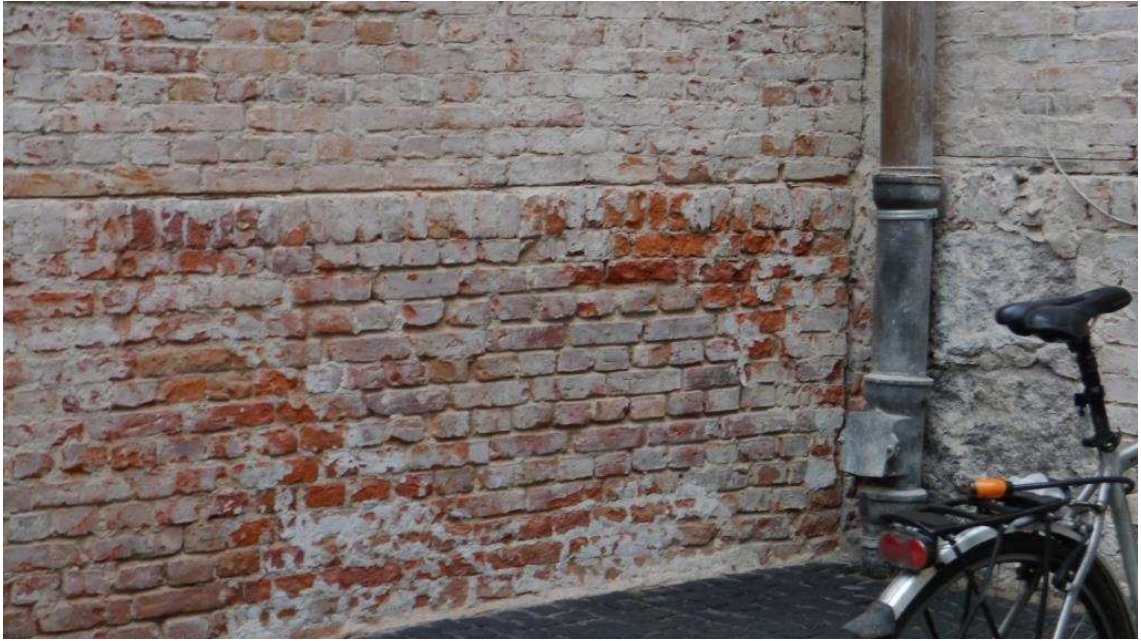
Zdj. nr 16. Stan muru części cokołowej. Widoczna dobudowa „na styk”
