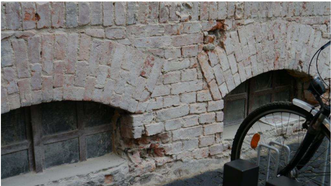
Zdj. nr 15. Nadproża murowane. uszkodzenia
