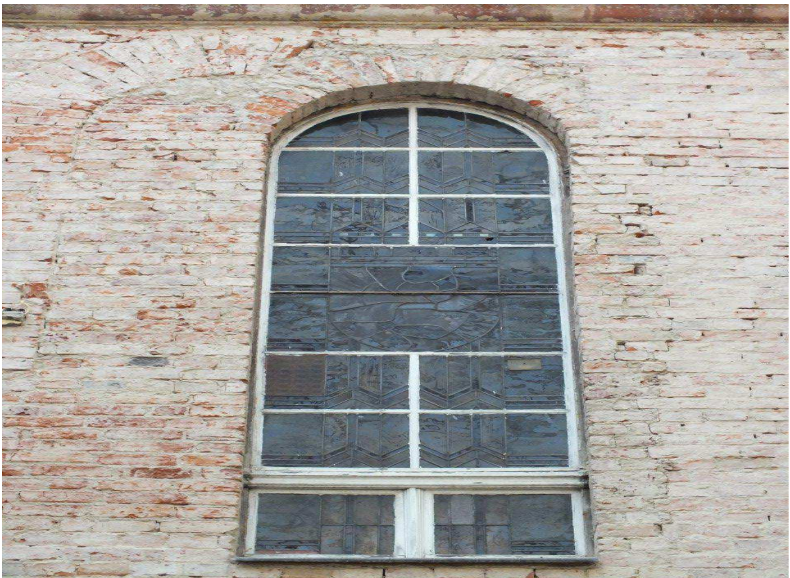
Zdj. nr 11 Stolarka okienna wraz z witrażem do renowacji
