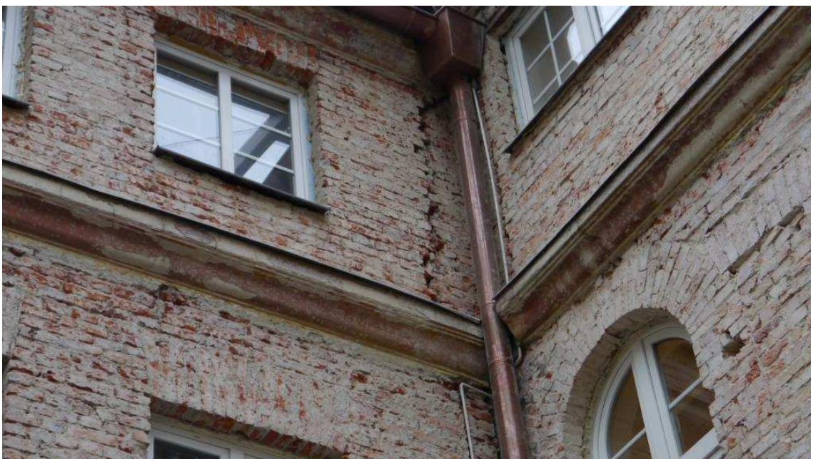
Zdj. nr 19. Uszkodzenia muru spowodowane nieuszczelnością rury spustowej
