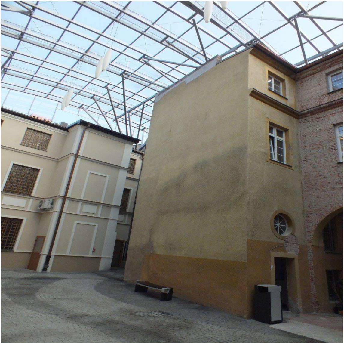
Zdj. nr. 8 Widoczne gzymsy do skucia na części elewacji podlegającej ociepleniu
